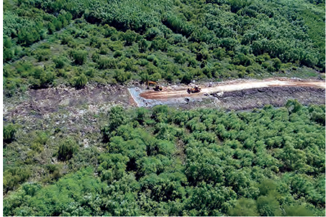
Frente de avance del terraplen sobre la traza desmontada.
