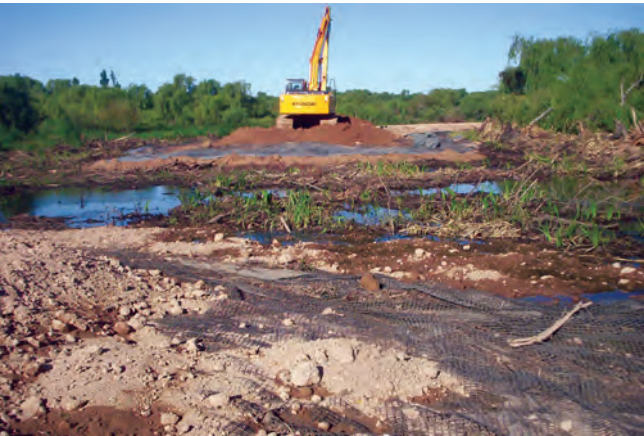
Estabilización de la base del terraplen (véase la escasa altura de la capa).
