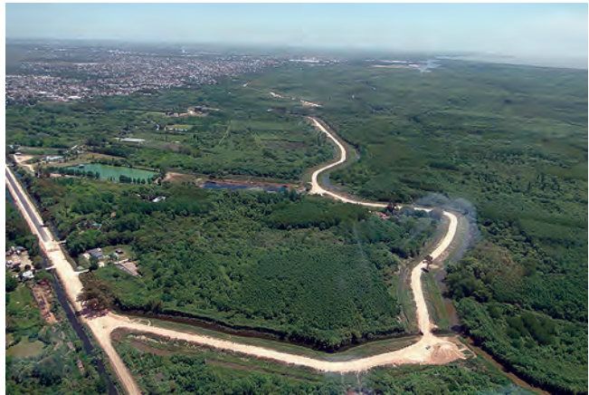
Vista aérea desde el sur de la obra en su etapa final.
