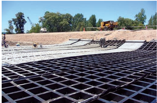
Ejecución in-situ del revestimiento sobre berma superior.
