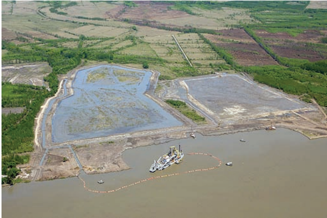
Dragado de la dársena y refulado de terrenos inundables.
