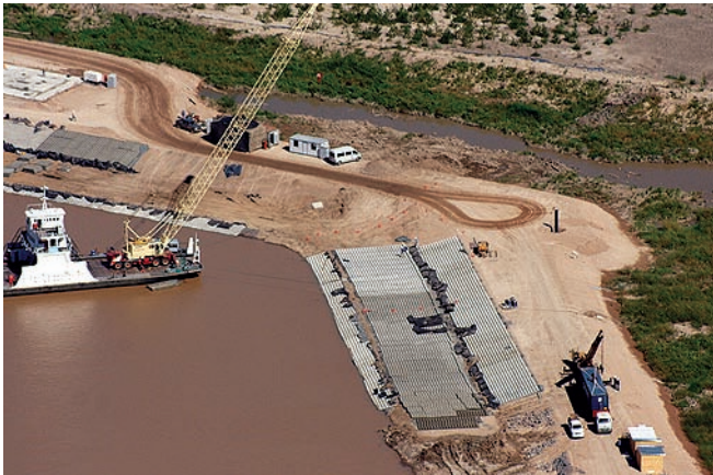
Colocación de mantas premoldeadas.
