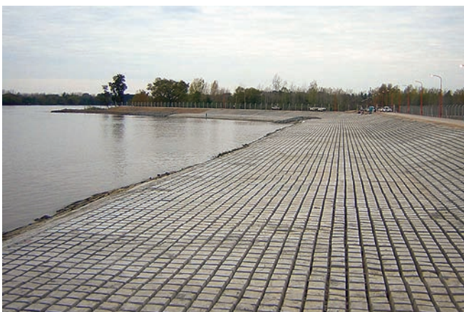
Revestimiento de berma y talud superior.
