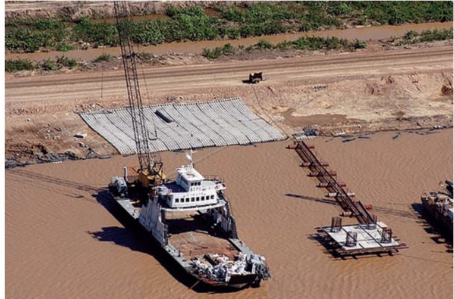
Mantas premoldeadas previas a su instalación.
