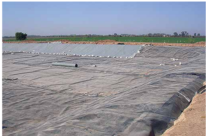
Instalación del geotextil PlusTex® sobre taludes
