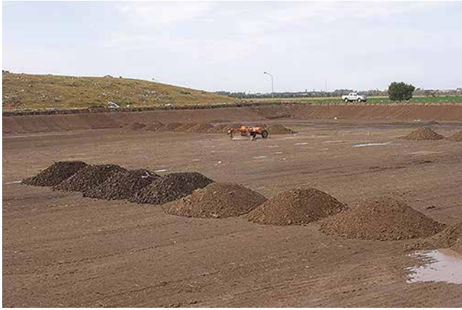
Nivelación y preparación de la subrasante
