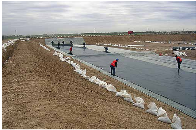
Colocación de PlusTene® (geomembrana PEAD).
