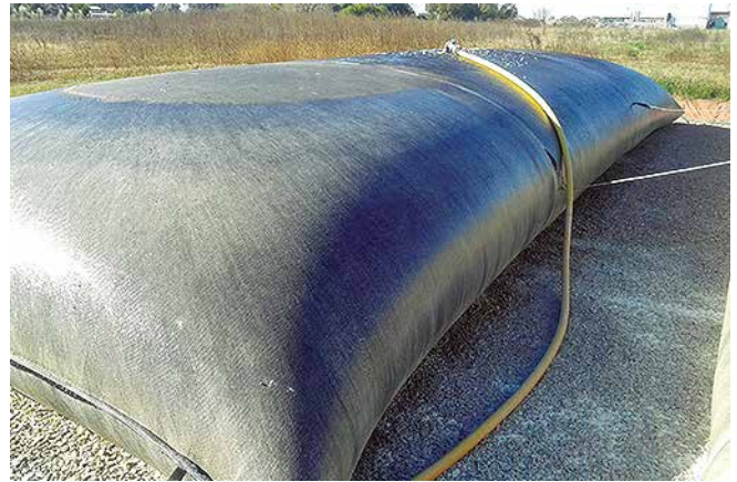
Proceso de llenado del geodesecador (filtrado de barros).
