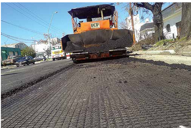
Terminadora colocando 2da base granular
