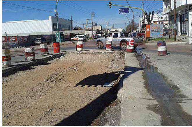
Reemplazo de losas deterioradas
