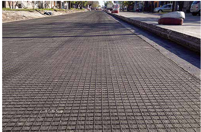
Geogrilla lista para colocación de 2da base granular
