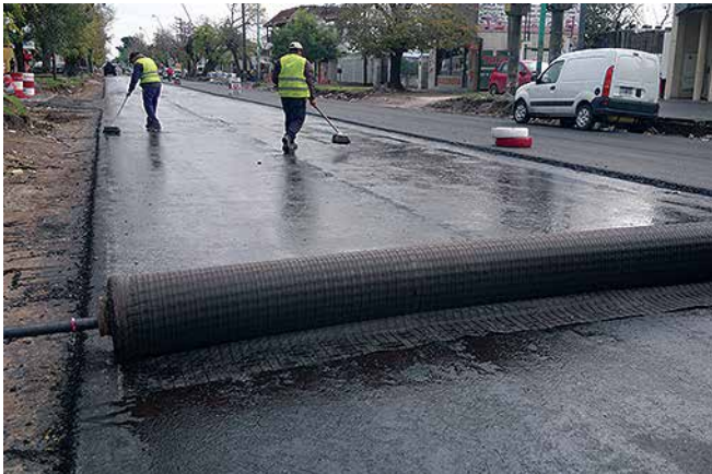
1er base granular regada, previo al desenrollado de Hatelit®
