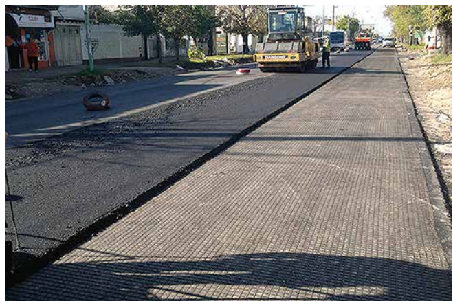
Rodillado de la 2da base granular
