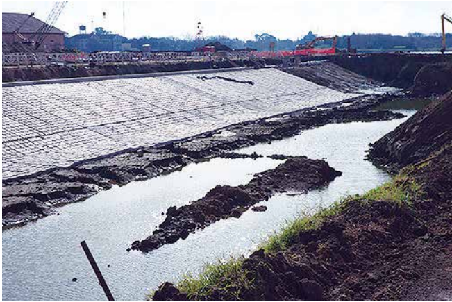
Montaje de BetonFlex® sobre talud en seco.
