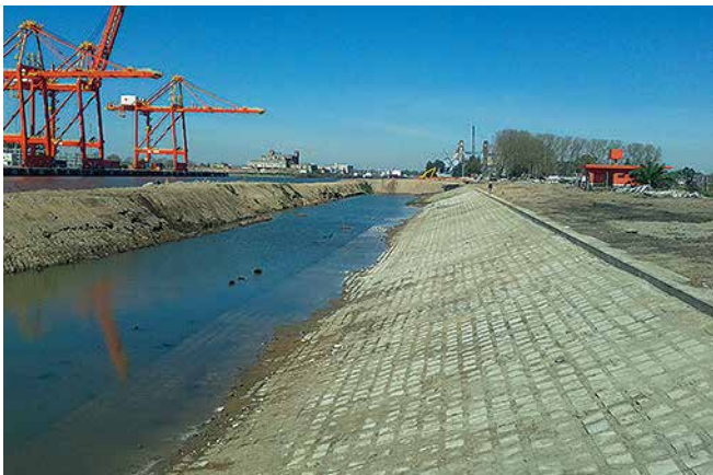
Finalización del revestimiento (previo a la apertura del canal).
