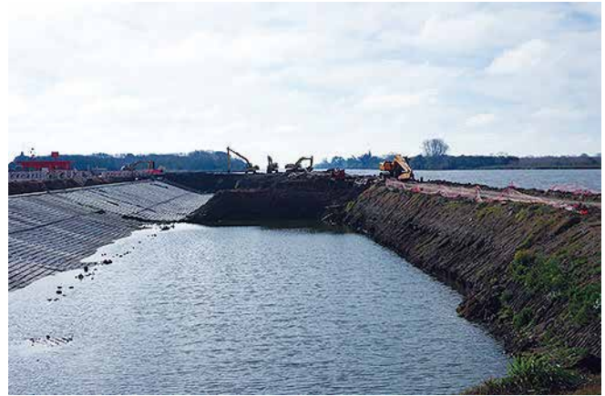
Excavación y ensanche del canal.
