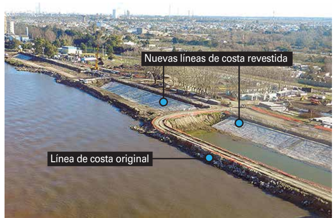
Vista aérea general de la obra.
