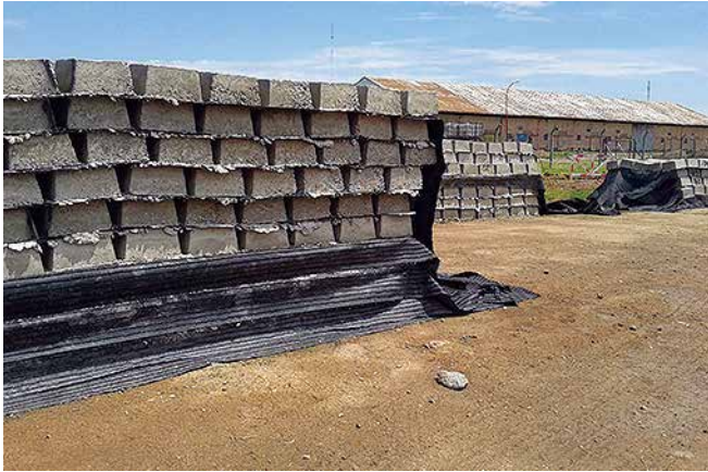
Zona de acopio en obra de mantas BetonFlex® .
