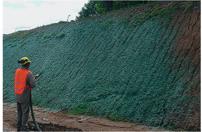
Aplicación de la hidrocobertura.
