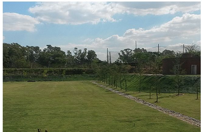
Vista general del reservorio terminado.
