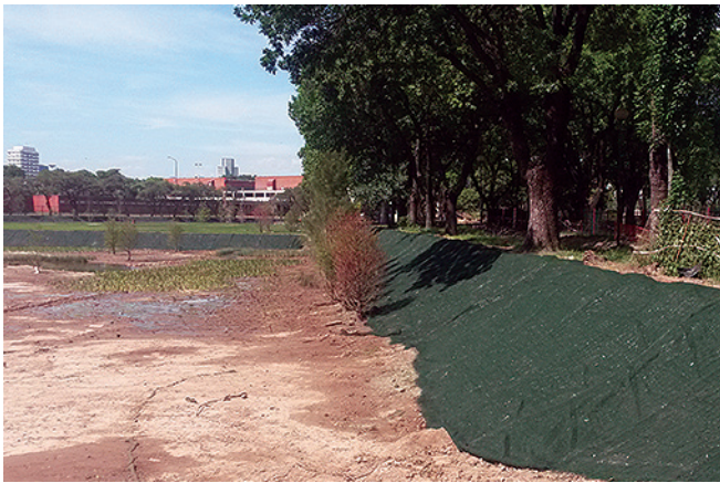
Instalación de geomanta LANDLOK ®
