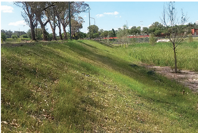
Resultado final de los taludes tratados.
