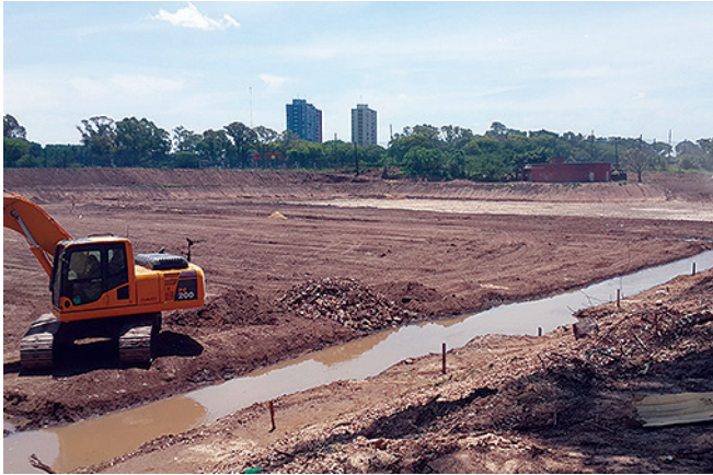
Excavación de los reservorios.
