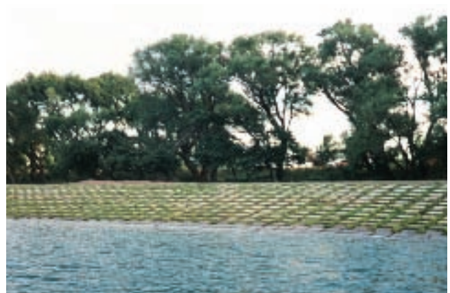
Vista general de la obra terminada.
