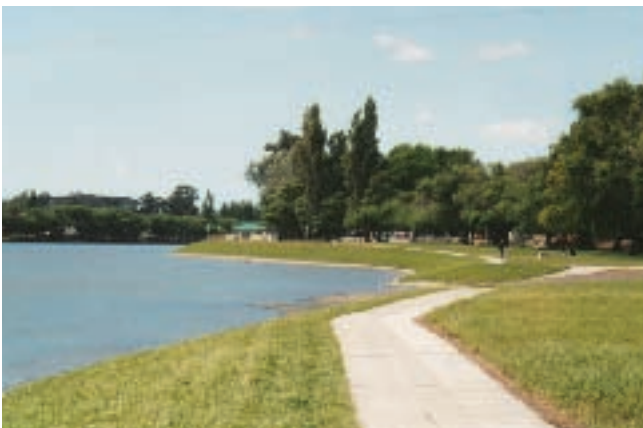
Vista revestimiento vegetalizado.
