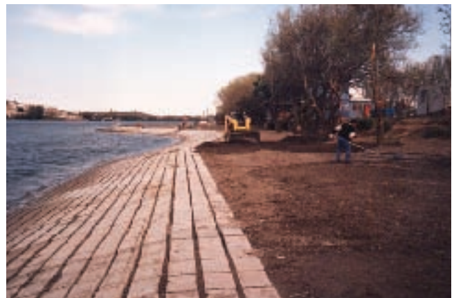
Vista revestimiento concluido.
