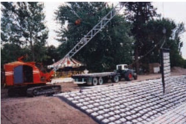
Instalación de las mantas de revestimiento BETONFLEX sobre filtro granular.
