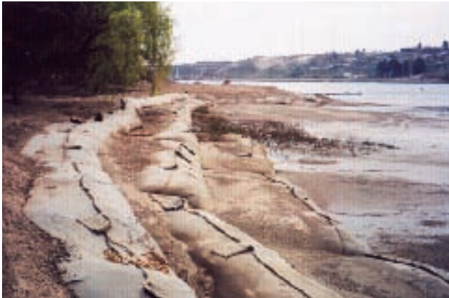
Reconstrucción de costa con geotubos de geotextil no tejido Bidim RT-21.
