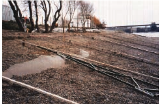
Ejecución del filtro granular.
