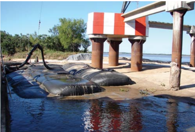
Estructura de confinamiento del relleno.
