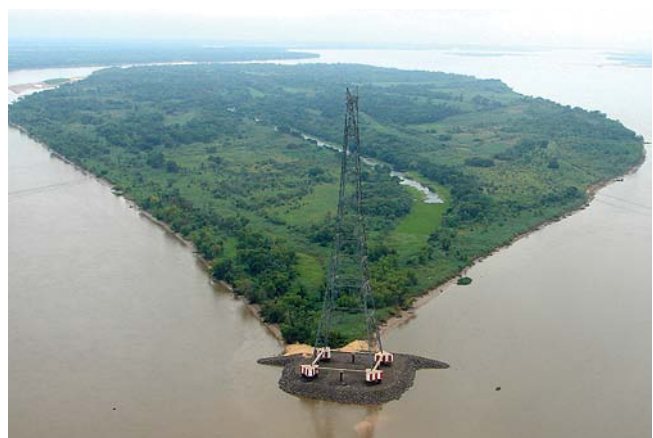
Vista de la obra terminada en la punta de la isla Guáscara.
