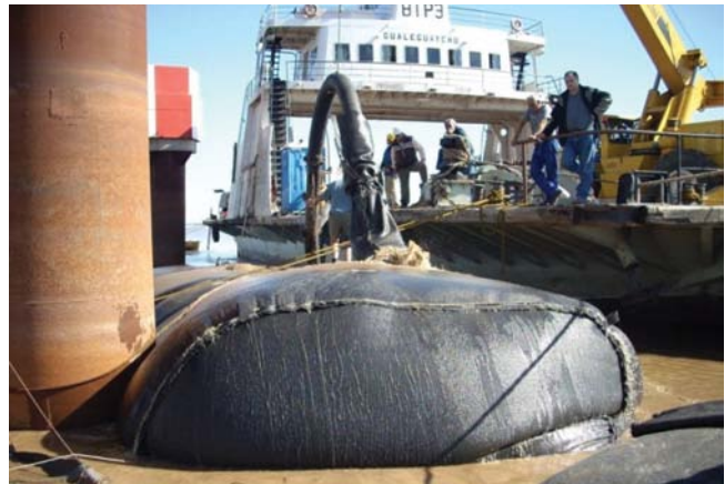
Llenado por refulado de un GeoTub®
