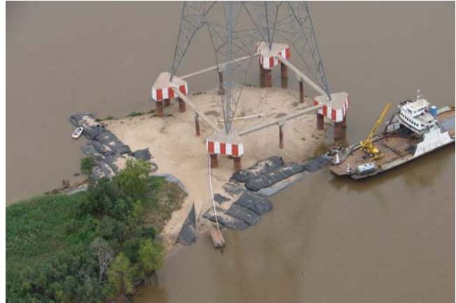
Ejecución del espigón sobre el brazo Guáscara.
