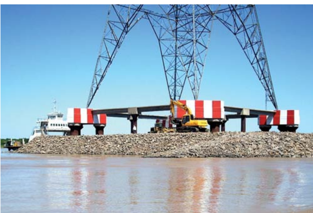
Trabajos finales sobre el enrocado de protección
