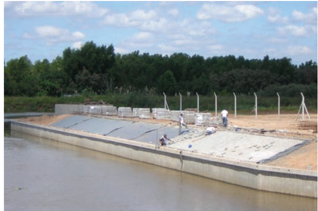
Colocación del revestimiento BetonPlan®
