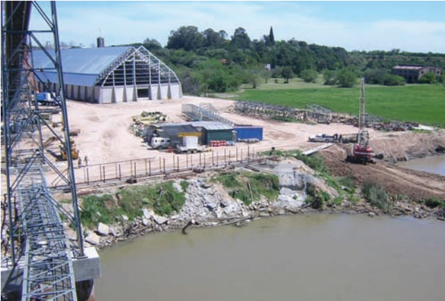
Trabajos previos de limpieza y regularización
