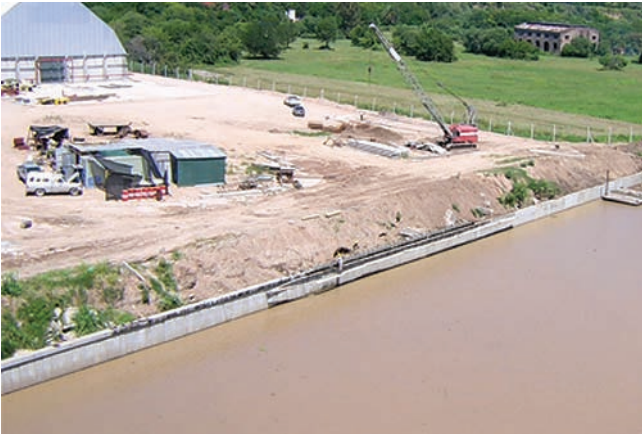
Ejecución avanzada del tablestacado
