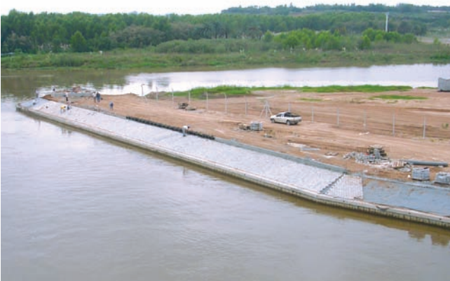
Trabajos finales en tramo aguas abajo del muelle
