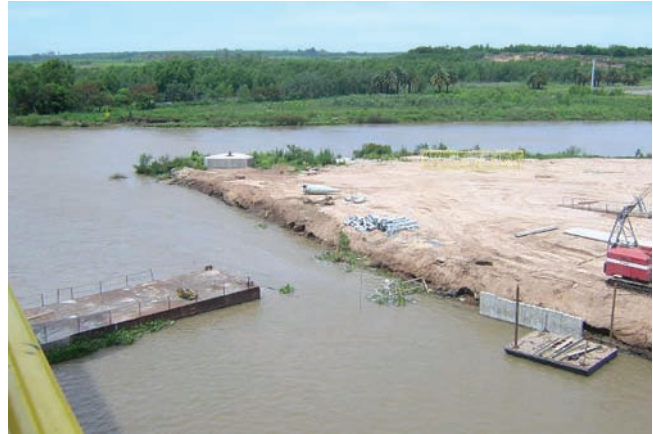
Inicio de la instalación del tablestacado
