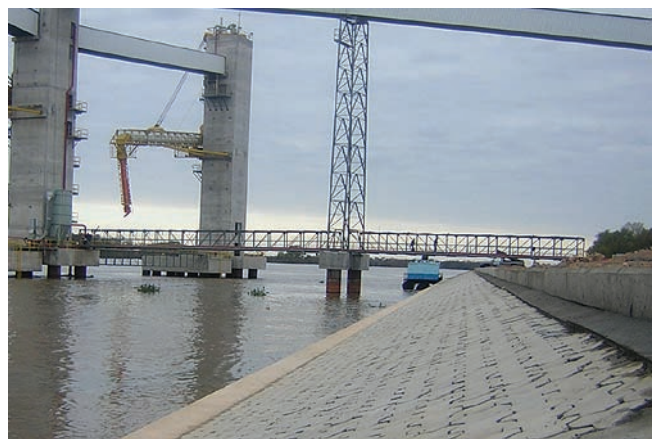
Vista parcial de la obra terminada
