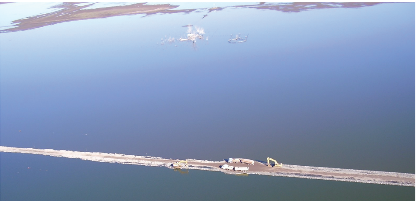
Vista general de un tramo de la obra
