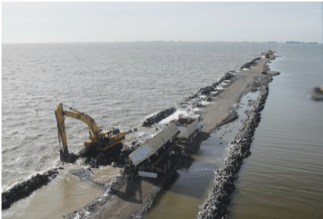
Ejecución de enrocados laterales
