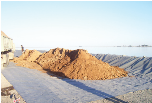
Descarga de suelo limoso sobre el getoextil
