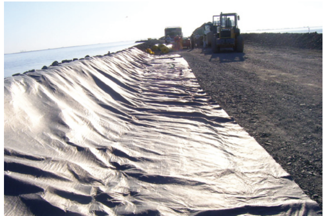
Instalación del geotextil Bidim sobre pedraplen
