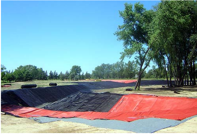
Geotextil, geomalla y geomembrana durante su instalación
