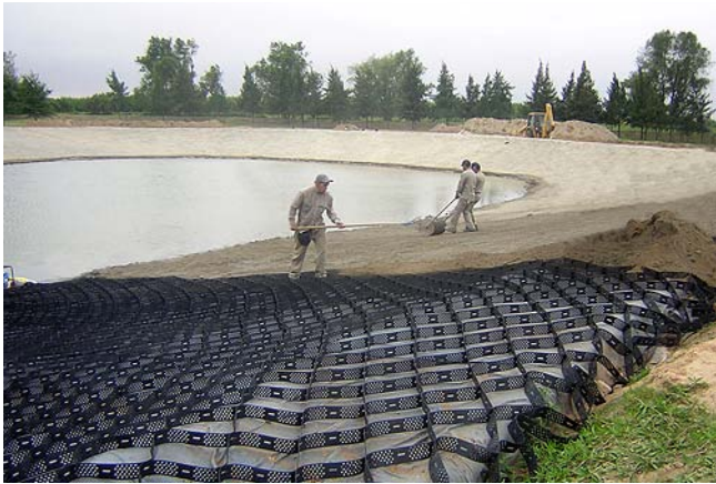
Geoceldas vacías y en proceso de relleno con suelo-cemento
