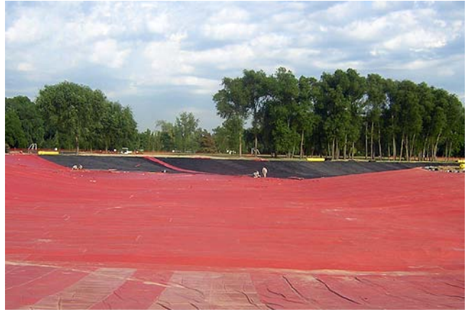
Vista de la superficie impermeabilizada
