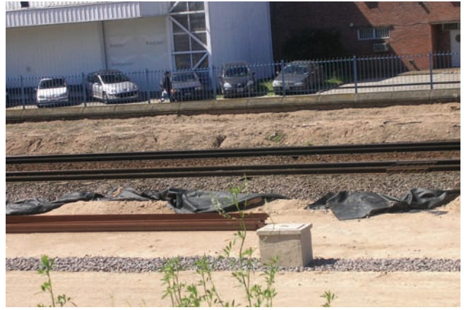
Plano de formación listo para recibir el balasto
