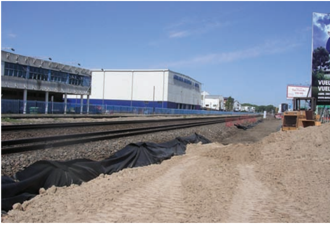
Apertura de caja y colocación del gtx. y del suelo seleccionado
