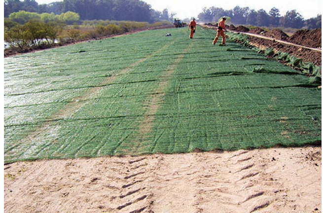
Colocación de la geomanta sobre terraplén reperfilado
