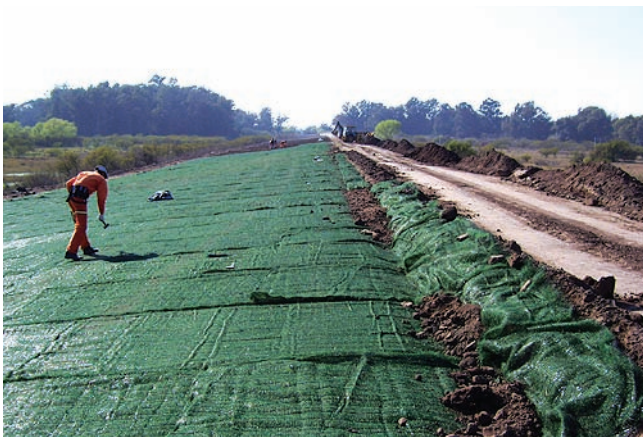
Zanja de anclaje en el coronamiento
