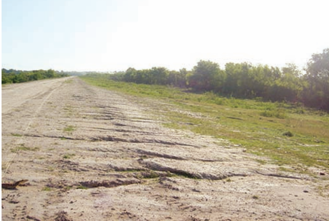
Estado inicial del terraplén.
