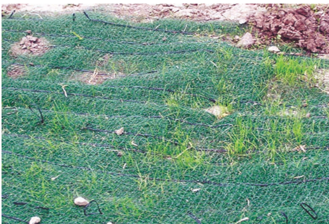
Plantas emergiendo a través de la geomanta
