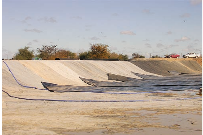
Colocación geomembrana PEAD sobre GCL
