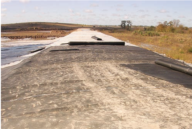
Impermeabilización terraplén lateral
