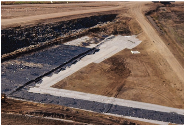
Vista parcial de un sector de la obra
