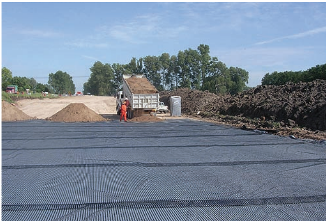
Inicio sobre relleno la geogrilla.
