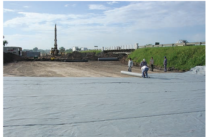
Instalación del geotextil Bidim como separador.
