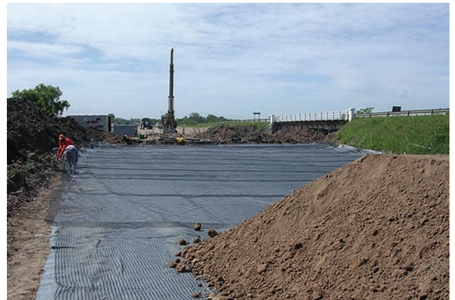
Vista de la obra hacia el puente A° La Arena.
