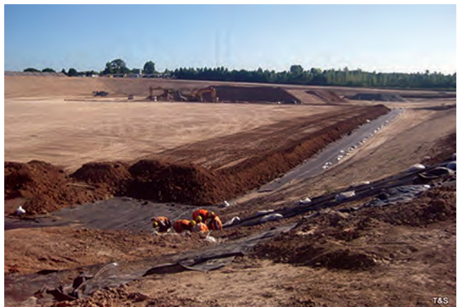
Colocación y avance del relleno sanitario dentro del recinto impermeabilizado
