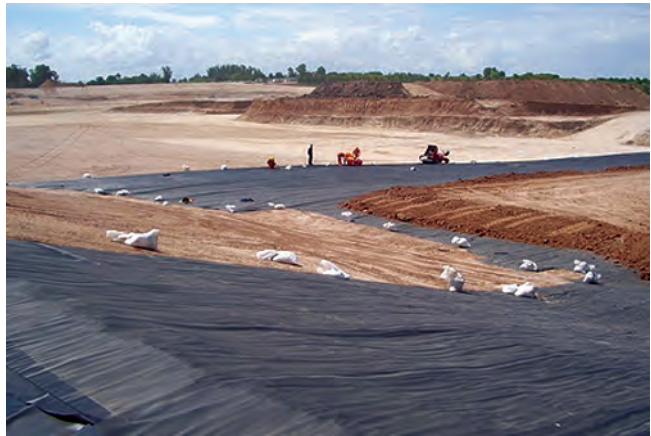
Unión de paños mediante soldadura Chemitak.
