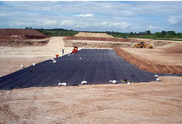
Ejecución de la soldadura de los diferentes paños.
