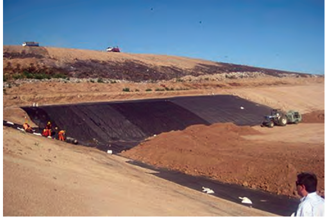
Recubrimiento de taludes (detrás RSU I Etapa)
