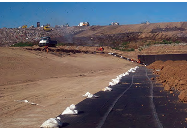
Colocación de capa protectora sobre geomembrana.
