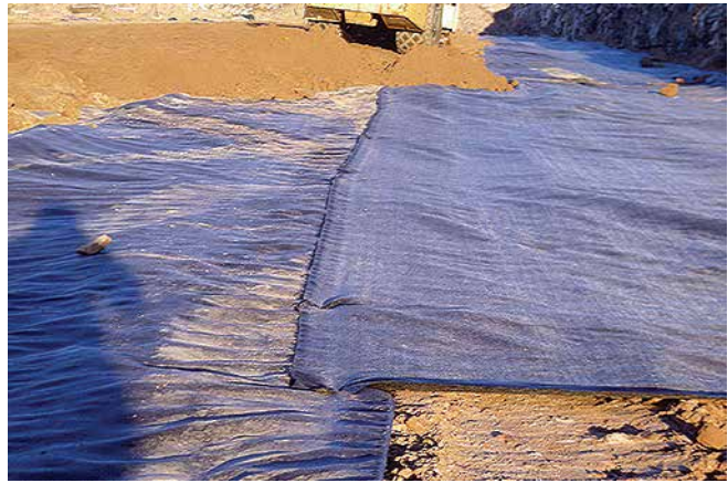
Superposición y anclaje de PlusTex® T J-480
