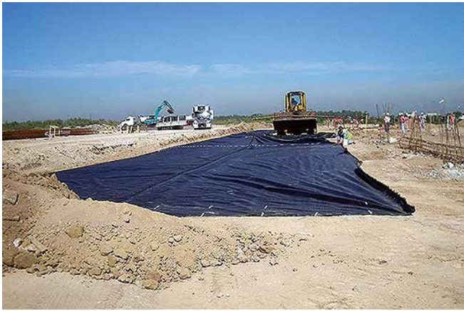
Instalación del geotextil PlusTex® T J-480
