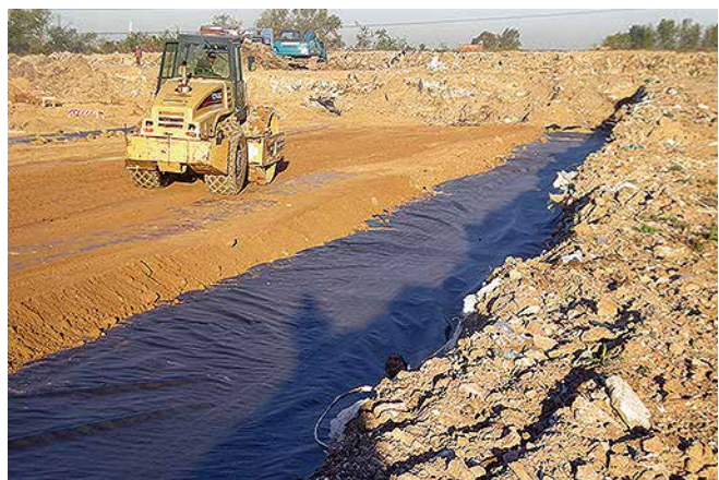
Compactación de capa de suelo seleccionado.
