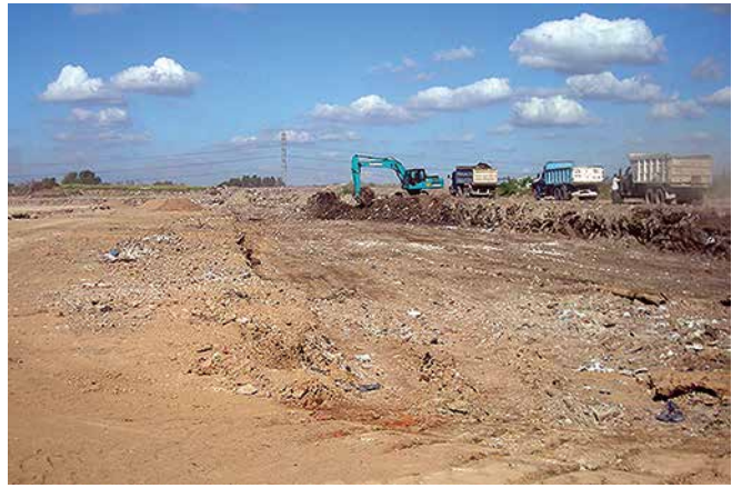
Destape y nivelación de la sub-rasante
