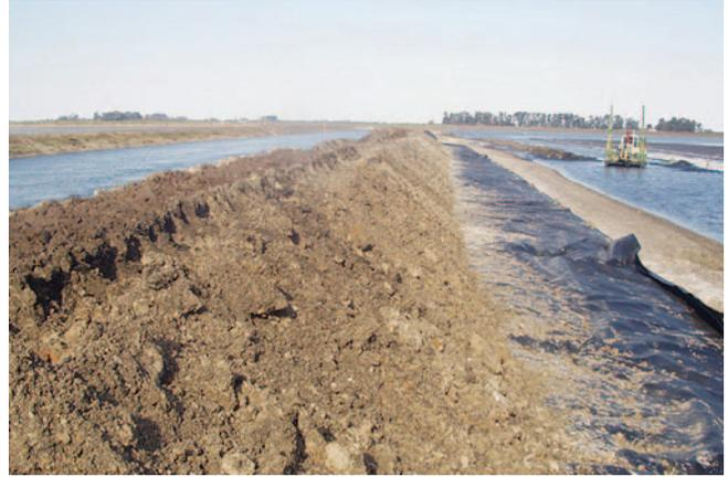
Carga del suelo sobre el geotextil.
