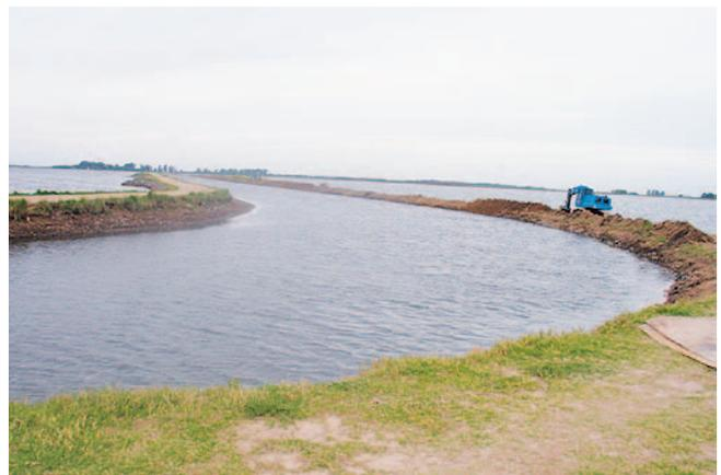
Talud reconformado con suelo confinado.
