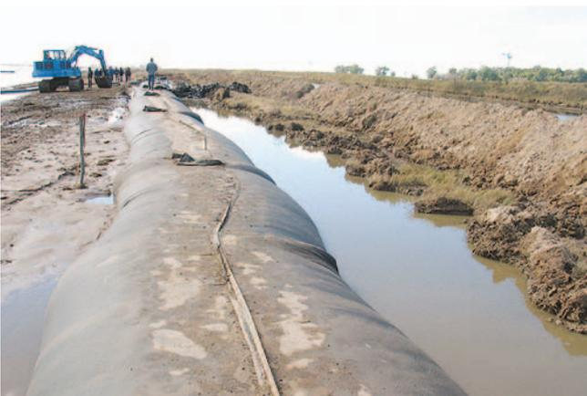
Geotubo en proceso de consolidación.
