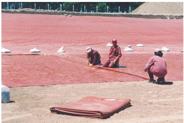
Disposición de geomembrana y soldadura de paños
