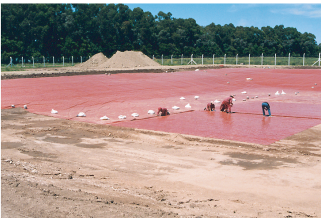
Impermeabilización de la celda.
