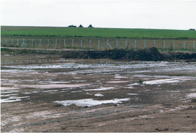
Estado del terreno previo a la excavación
