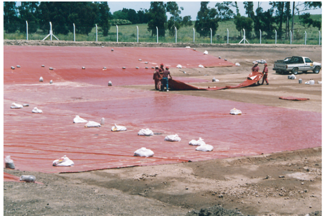
Impermeabilización del fondo de la celda
