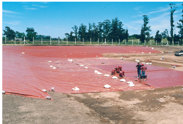
Vista general de la obra
