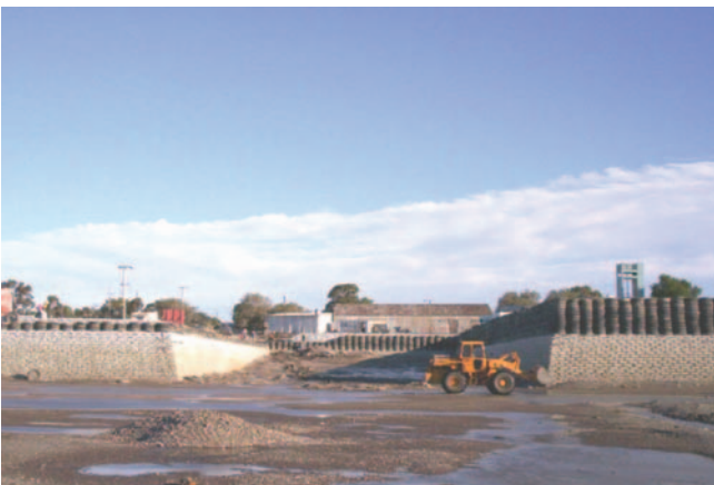
Vista general de la obra con marea baja
