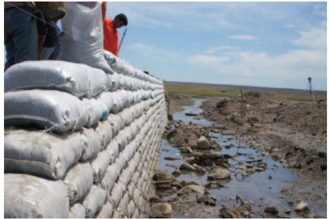
Colocación de bolsas de suelo cemento
