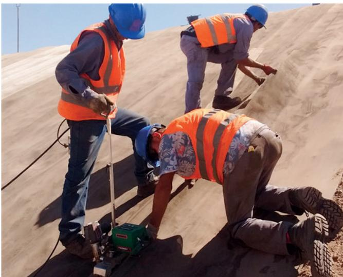
Soldadura por termofusión de mantas cementicias.
