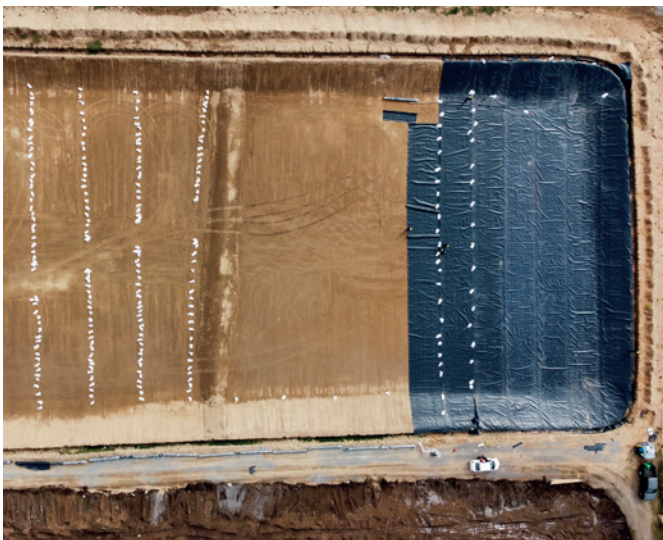
Despliegue de Plustene® celda 11 (inicio de obra)
