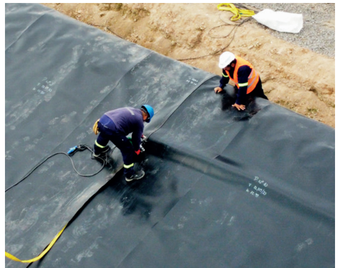
Unión de paños por termofusión
