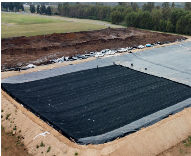
Despliegue de Plusdren® celda 11
