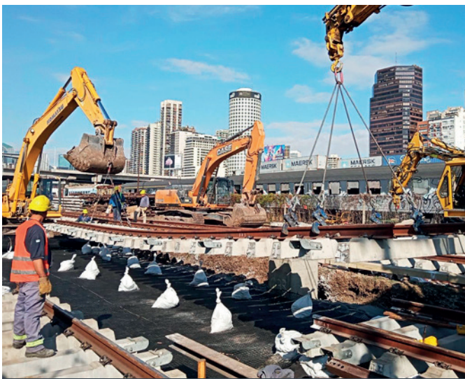
Montaje de tramo de vía sobre plataforma con geosintéticos
