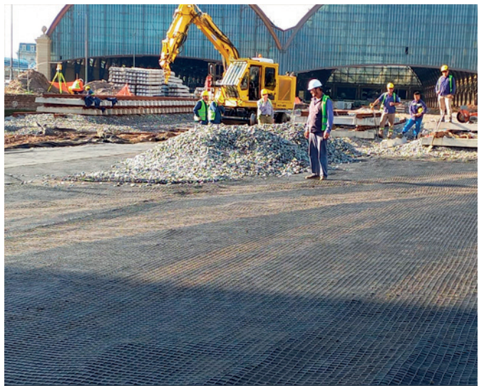
Colocación de balasto reciclado sobre el refuerzo geosintético
