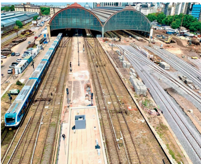
Avance de obra próximo a restablecer servicio con estación
