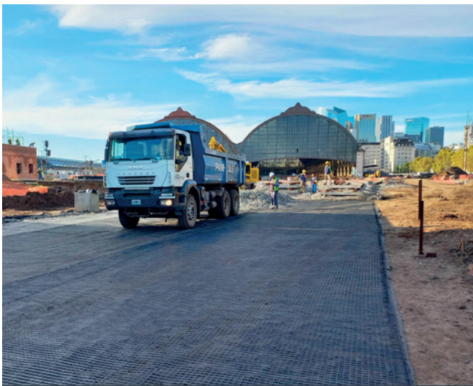
Despliegue de geotextil y geogrilla en el plano de formación
