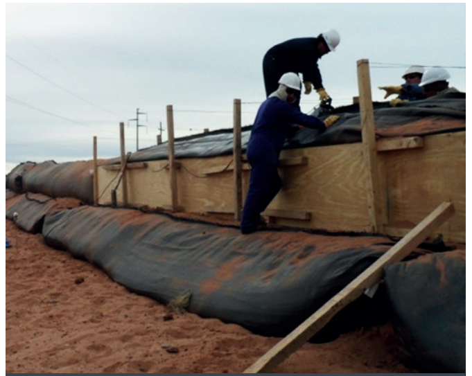
Cerrado de Geotubo® con costuras ejecutadas in situ.
