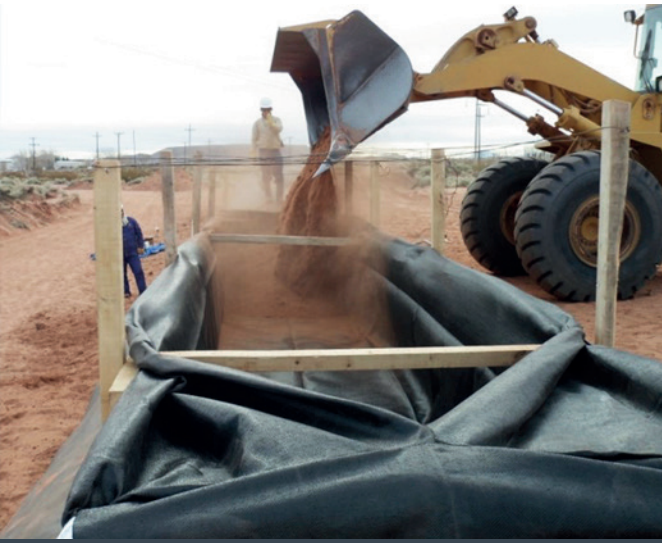
Lenado de Geotubo® con equipos medianos o menores. Vista del encofrado.
